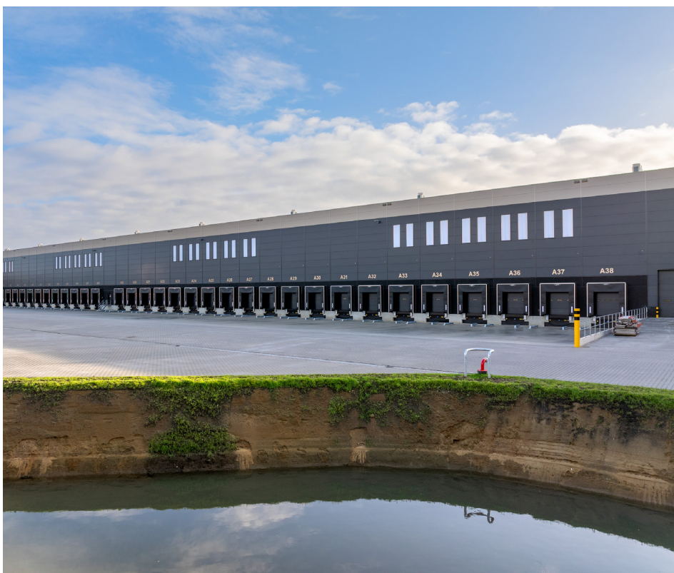
Er zijn wadi's aangelegd om hemelwater op te vangen.
