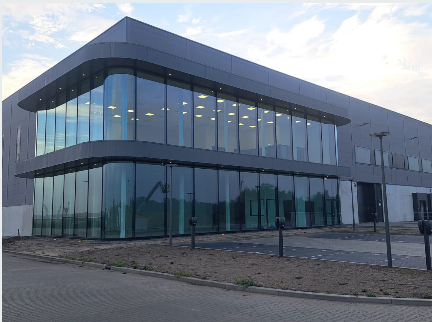
Boven: Het distributiecentrum is gebouwd volgens het Smartlog concept van DHG.
