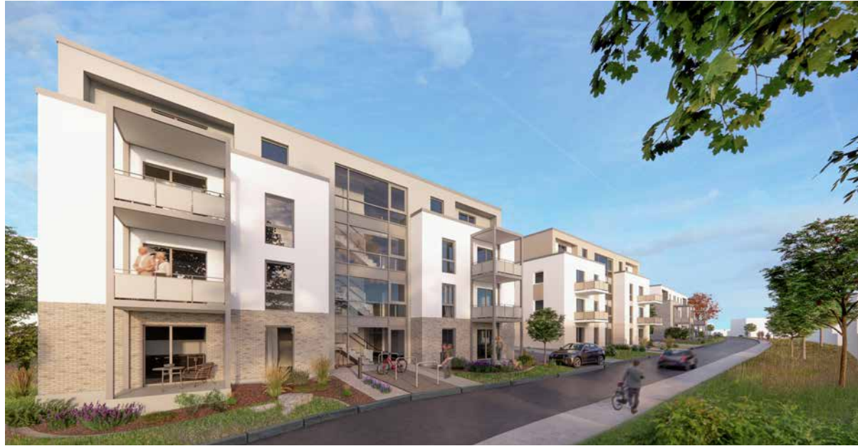
Wesertal, Bielefeld Andreas Kohl (Wesertal Erschließungs- gesellschaft mbH), 6.017 m 2 woonruimte, twee wooncomplexen met 72 woningen
