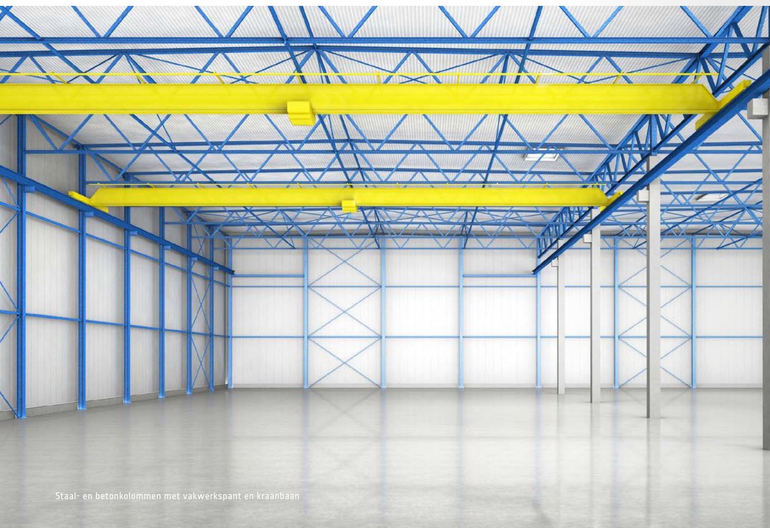
Prefab betonkolommen met vakwerkspanten
